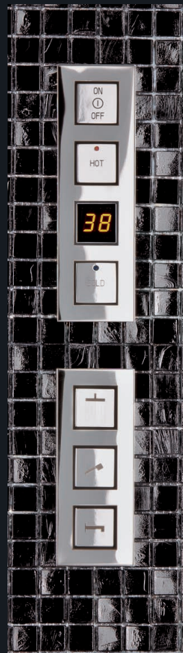
Bedientasten mit Chromrahmen (Tastatur) in Wannerrand und in einer Mosaikwand für eine Dusch-Badewanne mit zusätzlicher Kopfbrause
